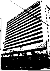
10 정우빌딩 업무시설 지하 3층, 지상 15층
