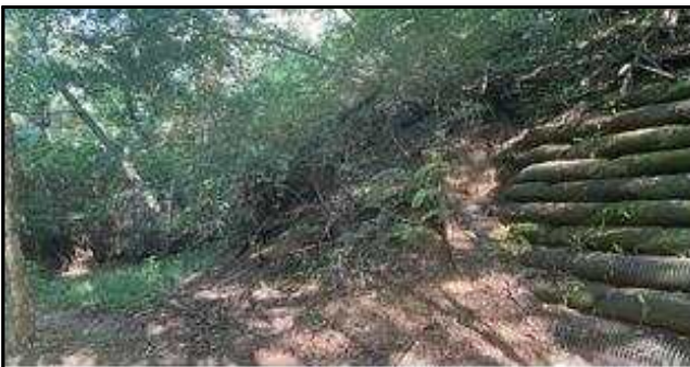
사방시설 정비 대상지(상암산)
