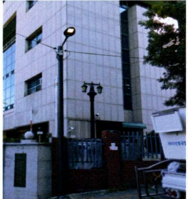
공사 후(노후 보안등 교체)
