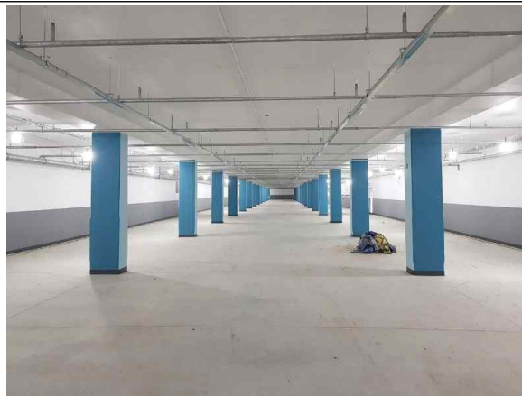
주차장 1동 내부
